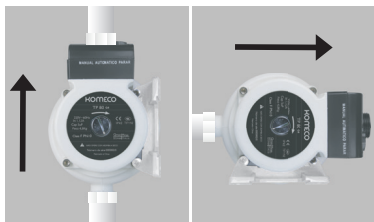
Posições incorretas de Instalação
