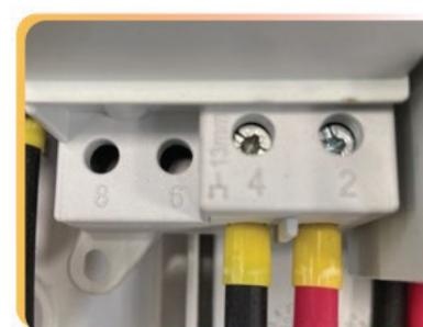
Exemplo de como devem ficar as conexões de entrada no Interruptor-seccionador.
