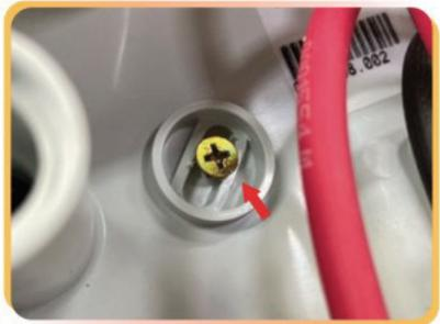
Após escolher o local de fixação, prenda sua String Box Komeco na superfície utilizando os parafusos enviados no seu Kit de Instalação.
