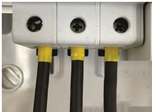
SEM CRIMPAGEM A CONEXÃO NÃO DEVE SER REALIZADA
