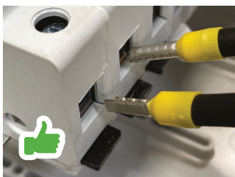
CRIMPAGEM CORRETA EXEMPLO CORRETO DE CONEXÃO
