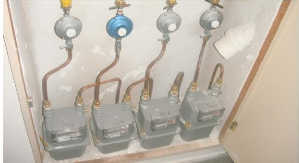
2. Foto de abrigo de medidor para utilização de aquecedores digitais com consumo de 5 kg/h, medidores corretos, mas regulador com registro reduzido e interligação em 3/8
