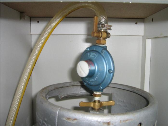
1. Foto de sistema ligado para aquecedor de passagem com regulador de gás 7 kg/h, registro 3/8 e mangueira homologada para fogões.
