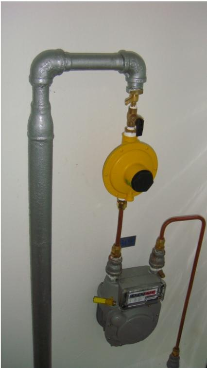
3. Montagem de cavalete para alimentação de gás de apartamento, para aquecedor com consumo de 4,8 kg/h, regulador de 12 kg/h mas com medidor e tubo de interligação insuficiente
